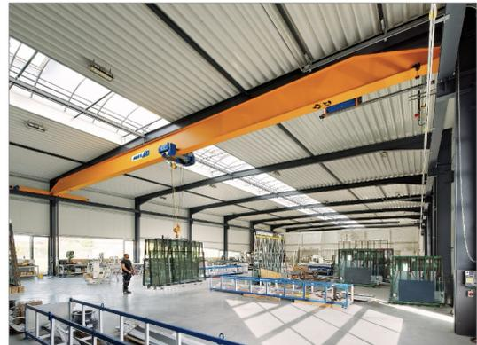
Tragfähigkeiten über 100 t und Spannweiten über 40 m sind möglich.
